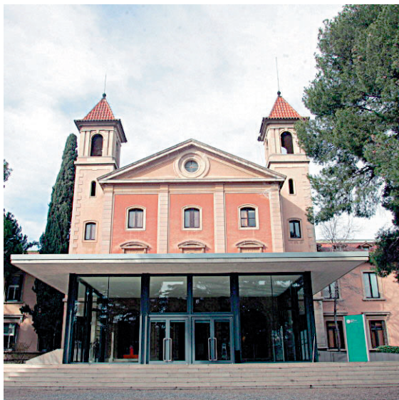
Exterior del edificio donde se ubica Mare Nostrum.
